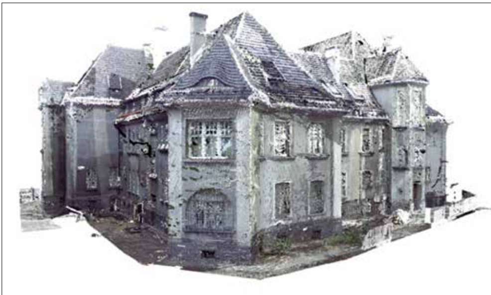
Rys. 1. Przykład inwentaryzacji z wykorzystaniem technologii chmury punktów – Sąd Rejonowy w Katowicach (rys.: www.bimpoint.pl)
