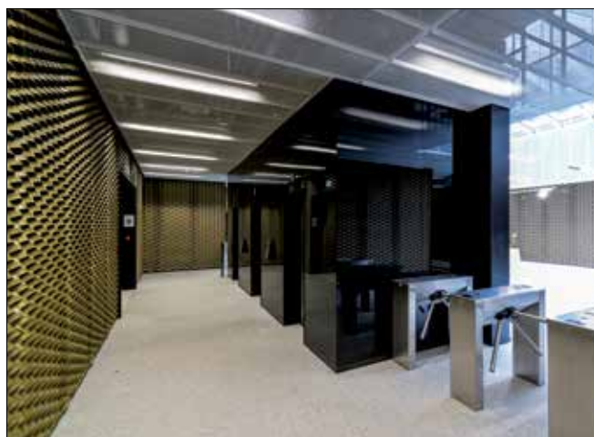
Fot. 2. Biurowiec Dominikański we Wrocławiu – sufit kasetonowy z siatki cięto-ciągnionej VARIO SCC, okładziny ściennie z formatek z elewacyjnej siatki cięto-ciągnionej
