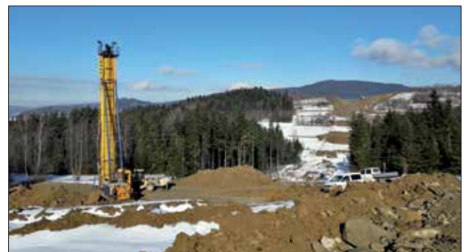
Fot. Droga ekspresowa S7 Kraków-Rabka Zdrój, odc. 1
