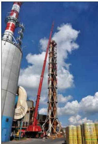
Wymiana przewodu spalinowego kominu H=60 m w wieży kratowej
