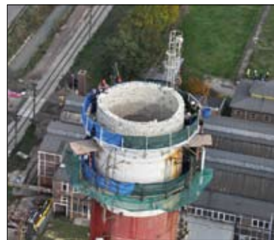
Odbudowa zwieńczenia kominu ceramicznego z użyciem materiałów kwasoodpornych
