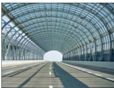
Budowa Drogi Ekspresowej S-8 na odc. węzeł Modlińska – węzeł Piłsudskiego, etap I
