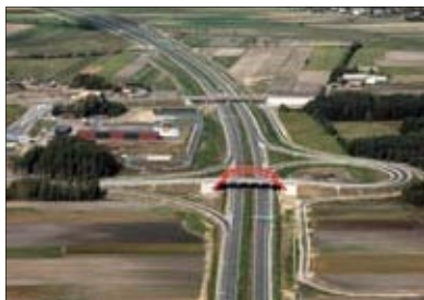
Autostrada A1 Toruń – Stryków
