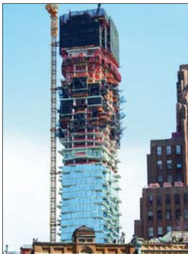
Budynek apartamentowy 56 Leonard Street (h=250 m), Nowy Jork, USA. Projekt i wdrożenie – PERI Polska
