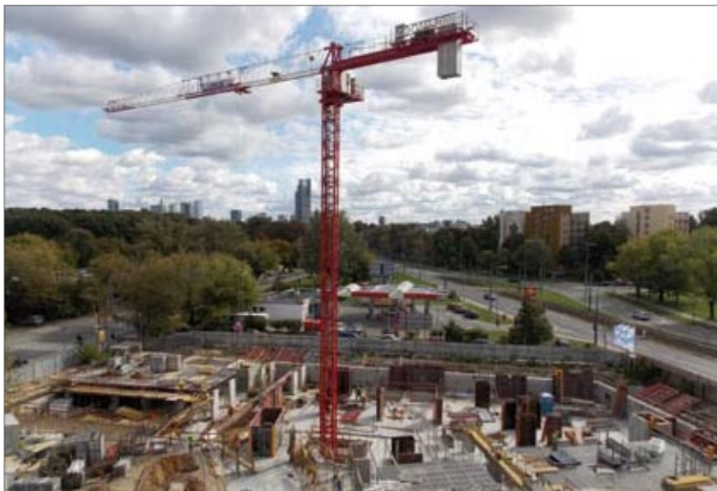
Budowa osiedla Wola Tarasy, Warszawa
