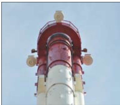
Projekt i zabudowa zestawu tłumików drgań dla kominu stalowego H=120 m zamontowanych po awarii tłumika masowego
