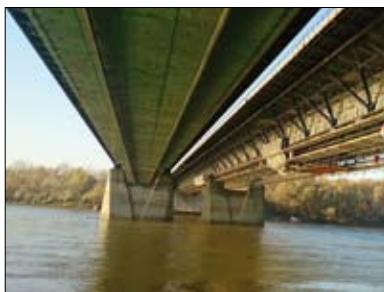
Przebudowa drogi S8 na odcinku węzeł Powązkowska – węzeł Modlińska, etap II
