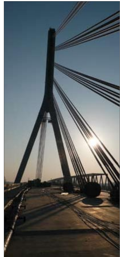
Montaż want DSI w systemie DYNA Grip®
