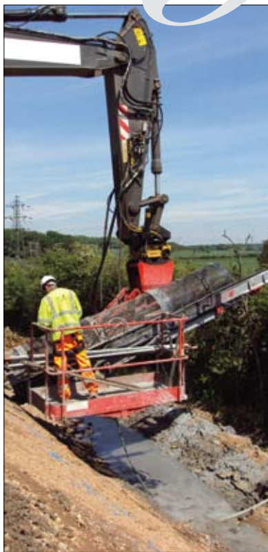
Instalacja gwoździ gruntowych DYWI® Drill
