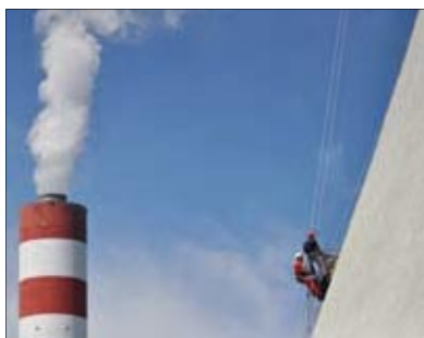
Badania stanu technicznego chłodni kominowej
