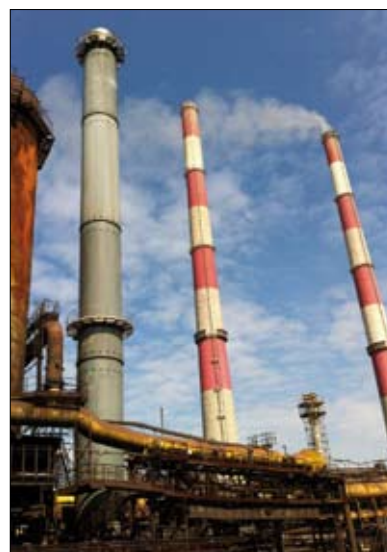
Budowa kominu stalowego dwupłaszczowego H=60 m wyposażonego w 8 tłumików drgań
