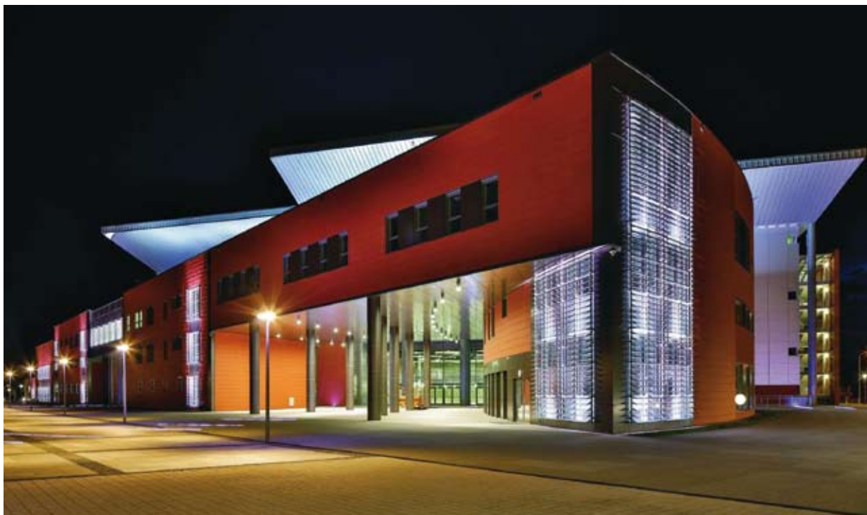
ARENA Szczecin – przy budowie wykorzystano kasetony elewacyjne Blachy Pruszyński
