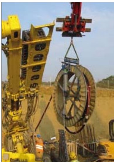
Instalacja kotew linowych DSI rozwijanych z bębna
