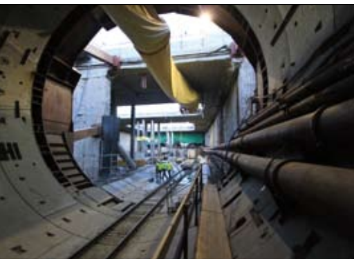
Tunel podziemny pod Martwą Wisłą w Gdańsku
