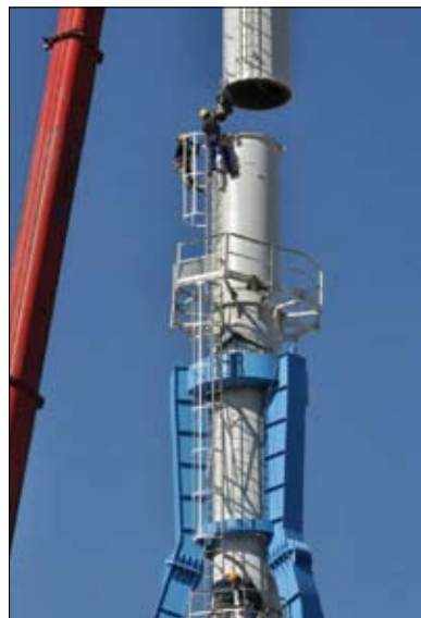
Przebudowa kominu stalowego w trójnogu na komin dwupłaszczowy z przewodem ze stali kwasoodpornej
