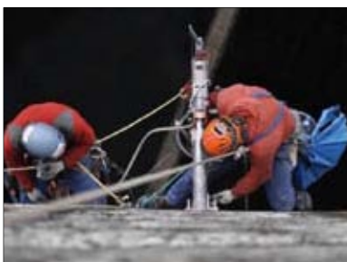
Odwierthy w płaszczu chłodni w ramach ekspertyzy stanu technicznego
