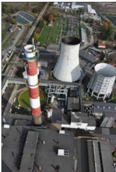
Skrócenie i przebudowa kominu ceramicznego H=110 m
