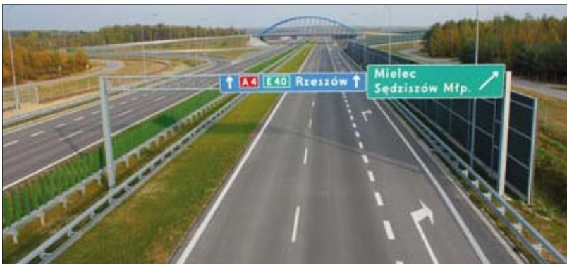
Autostrada A4 Dębica – Rzeszów
