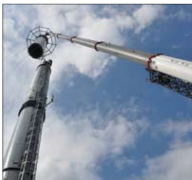
Montaż ostatniego segmentu kominu dwupłaszczowego
