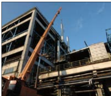
Wymiana kominu ze stali nierdzewnej z ociepleniem
