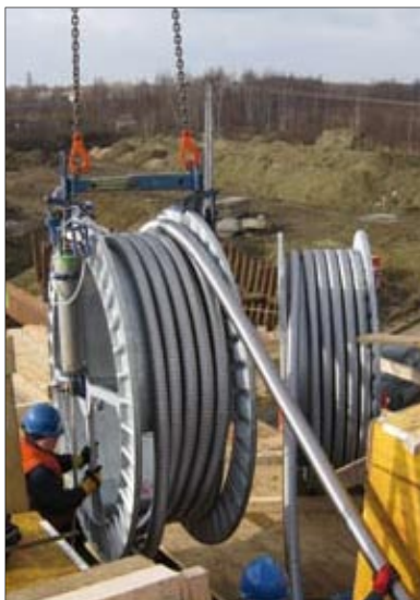
Instalacja prefabrykowanych kabli sprężających DSI
