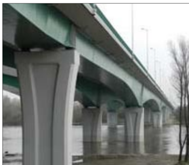
Most Północny w Warszawie
