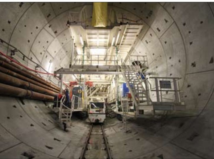
Tunel pod Martwą Wisłą w Gdańsku
