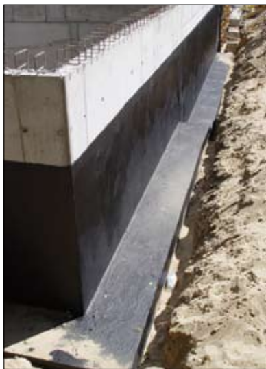
Bitumiczna hydroizolacja pionowa fundamentów
