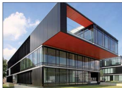
Wilanów Office Park, Warszawa
