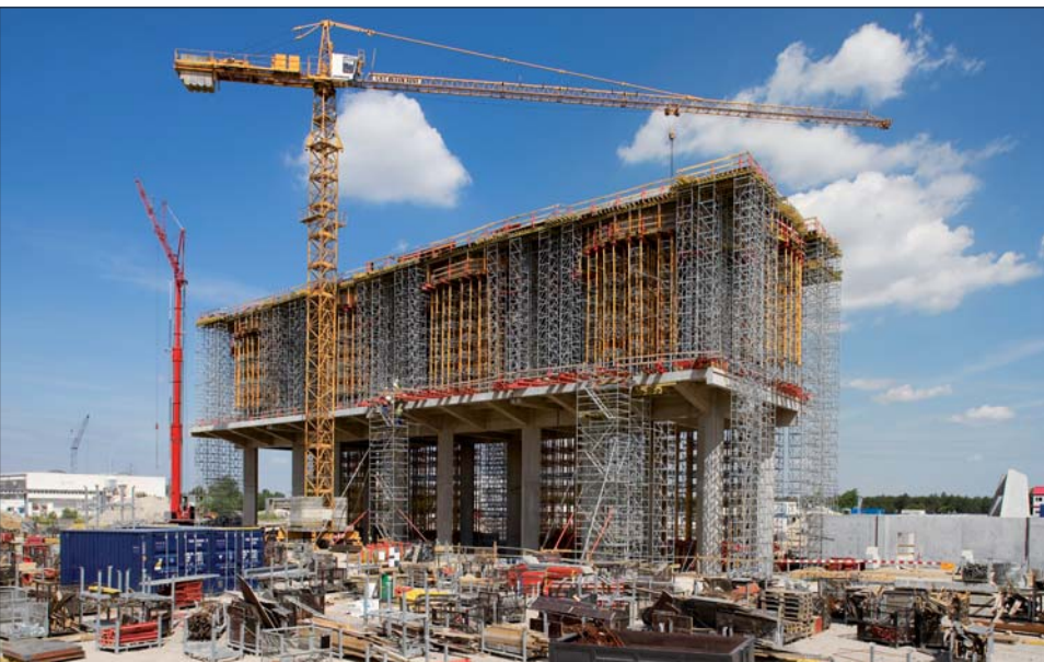
Budowa bloku energetycznego elektrowni Bełchatów
