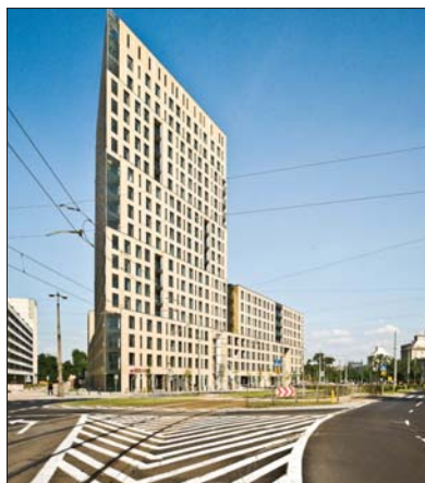
Budynek mieszkalny Trio, Warszawa
