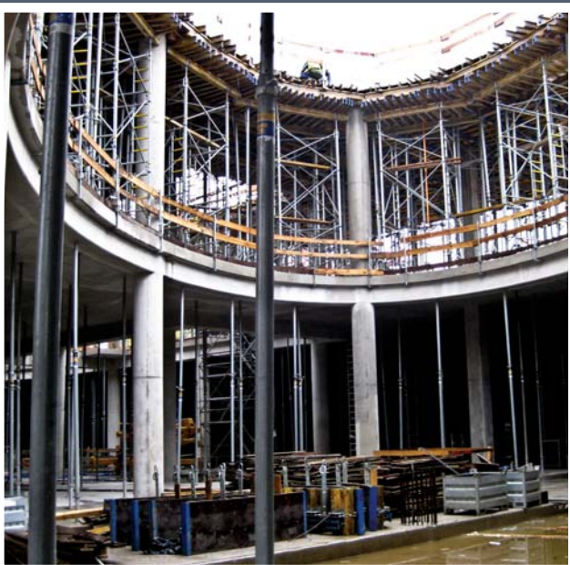
Sky Tower. Ponad dwumetrowy budynek w centrum Wrocławia realizowany przez spółkę LCC. Jedną z najbardziej prestiżowych budowli tego miasta. Doka dostarczyła deskowania ścienne Framax Xlife i stoliki stropowe Dokamatic do konstrukcji części galeryjnej wieżowca. Klient: Rondo Bau Konstrukcje Sp. z o.o.
