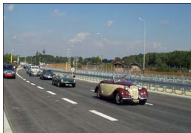
Kraków, ul. Tischnera (jezdnia na terenie o słabej nośności gruntu posadowiona na nasypie z Leca® Keramzytu, wys. 1,0-3,5 m, objętość 9 tys. m 3 )
