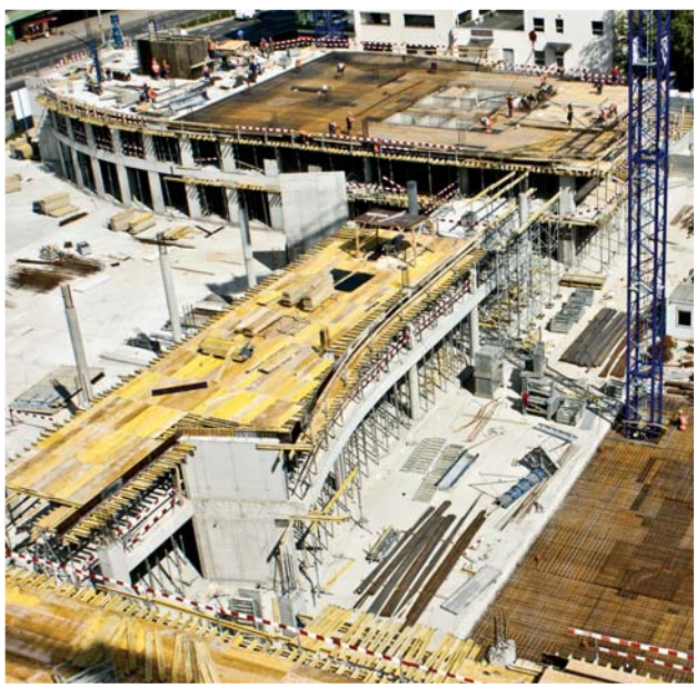
New City. 13-kondygnacyjny budynek biurowy w Warszawie realizowany w technologii słupowo-stropowej. Doka zapewniała deskowania ścienne i stropowe w czasie całej budowy. Klient: Consteel Sp. z o.o.
