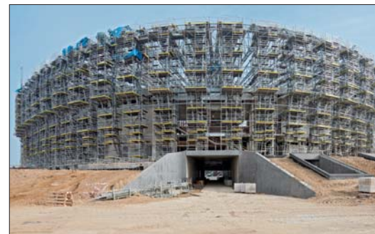
Budowa stadionu PGE Arena Gdańsk
