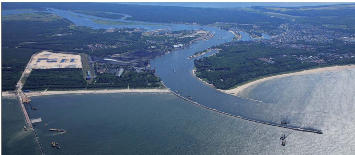
Budowa falochronu gazoportu w Świnoujściu
