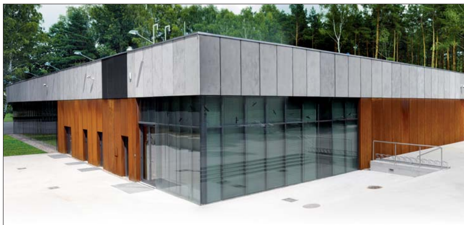
Muzeum w Palmirach. Elewację obiektu wykonano z dostarczonych przez Ruukki blach płaskich Cor-Ten o unikatowym wyglądzie i podwyższonej odporności na korozję
