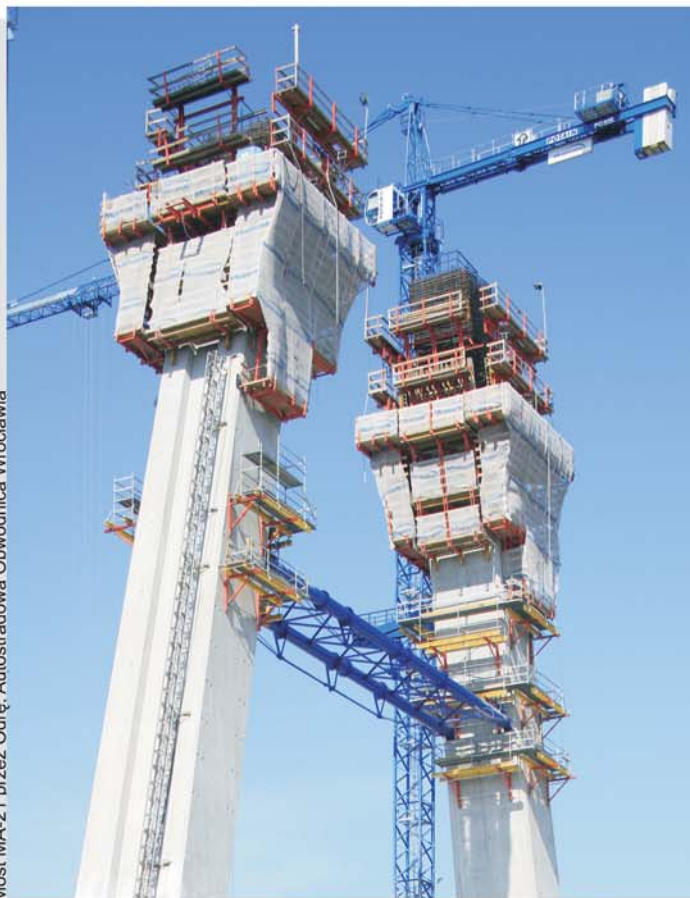
Most MA-21 przez Odrę, Autostrada Obwodnica Wrocławia
