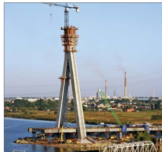
Budowa mostu pylonowego Jana Pawła II, Gdańsk
