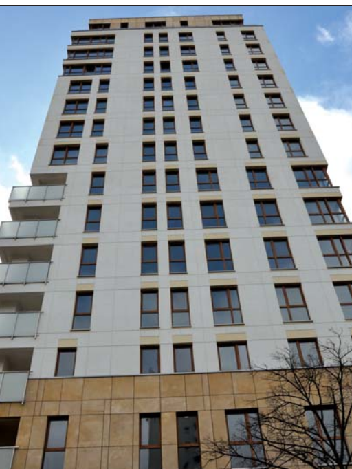
Gdańsk, Quattro Towers (elewacja w technologii Weber, pow. ok. 18 tys. m 2 )
