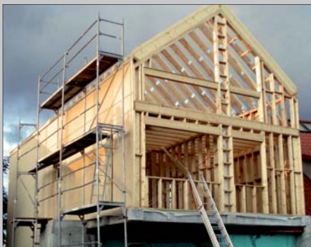
Budowa – wykonanie szkieletu drewnianego
