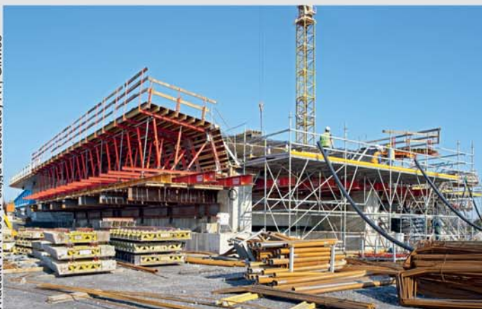
Wiadukt WA 458 w ciągu autostrady A1, Gliwice
