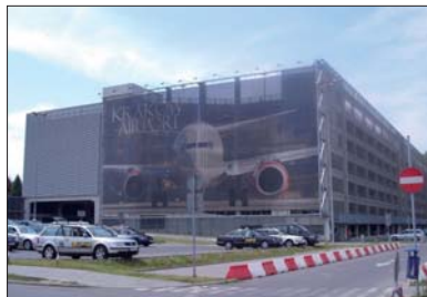
Kraków, port lotniczy Balice (parking wielopoziomowy, w którym wykorzystano hydroizolacje i posadzki powierzchniowo utwardzane Weber Deitermann, 25 tys. m 2 )
