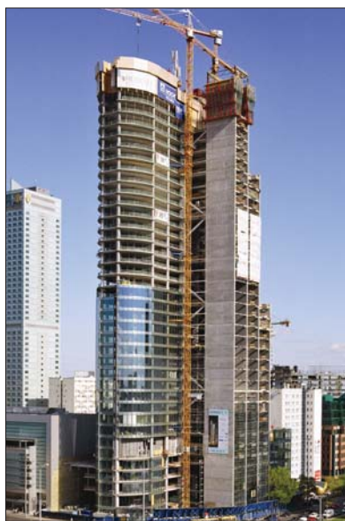
Budowa wieżowca Rondo 1, Warszawa
