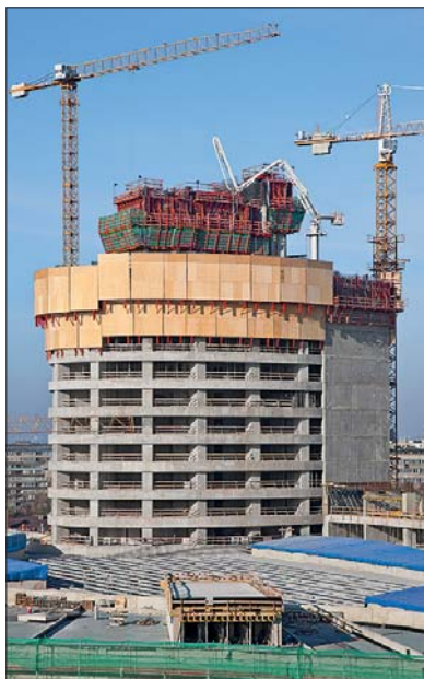
Budowa Sky Tower, Wrocław
